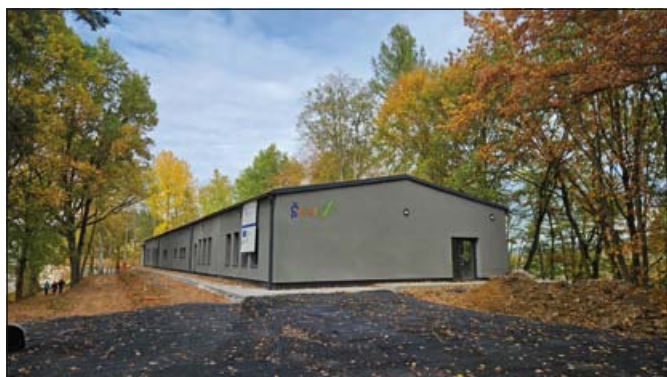
Vzdělávací středisko Šešule budova po realizaci
