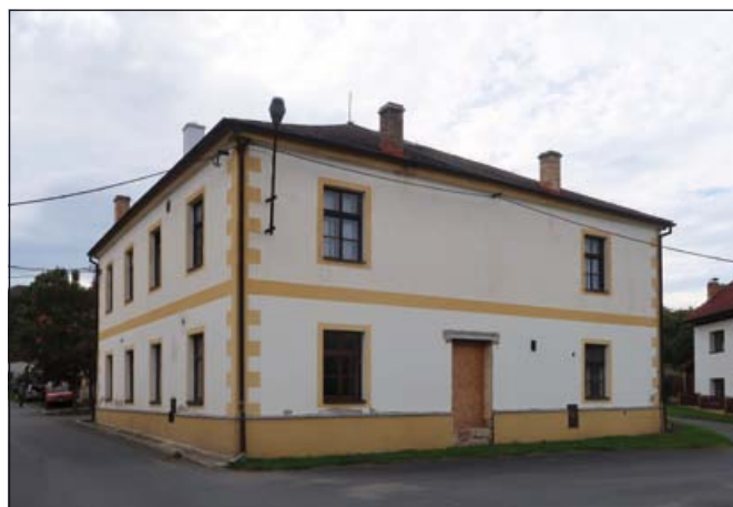
Rekonstrukce spolkového domu v Chorušicích
